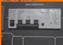
Рис. 13 Автомат защиты 30 мА Трехфазный
