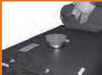
Рис. 3 Заправка топлива Генератора в шумозащитном кожухе
