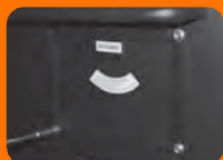
Рис. 11 Воздушный фильтр генератора в шумозащищенном кожухе.
