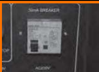
Рис. 12 Автомат защиты 30 мА Однофазный
