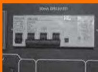
Рис. 13 Автомат защиты 30 мА Трехфазный.
