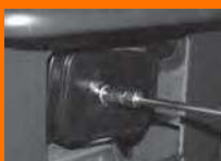
Рис. 11 Воздушный фильтр генератора в шумозащитном кожухе.
