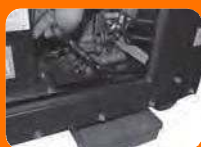
Рис. 27 Слив масла у генератора в шумозащитном кожухе
