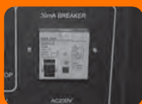
Рис. 12 Автомат защиты 30 мА Однофазный
