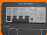
Рис. 13 Автомат защиты 30 мА Трехфазный
