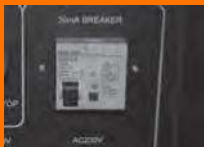
Рис. 12 Автомат защиты 30 мА Однофазный.
