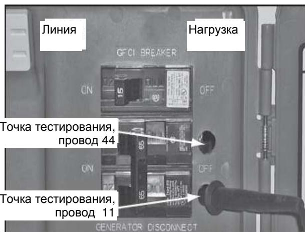
Рисунок 5. Испытательные точки для проведения теста 7.
